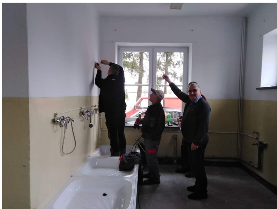
Fotografia 7 Przygotowywanie pomieszczeń w Ośrodku dla Uchodźców z Ukrainy
