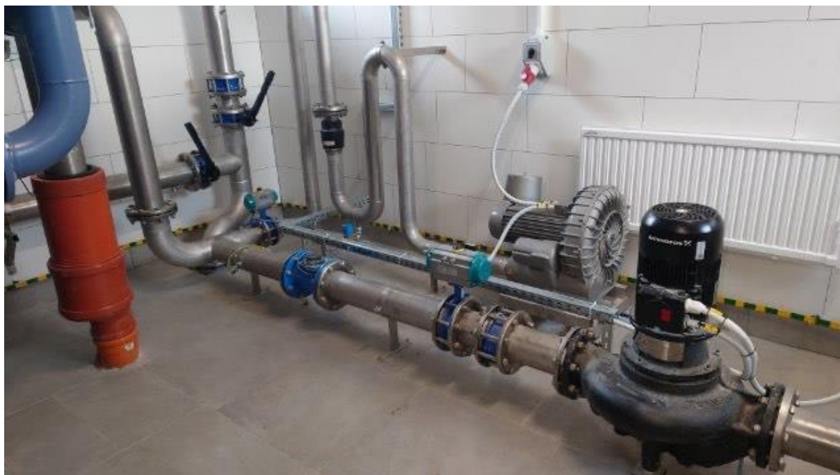
Fotografia 6 Stacja Uzdatniania Wody w Wólce Nosowskiej
