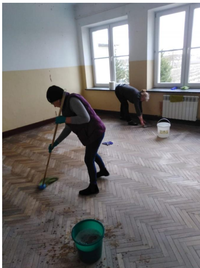
Fotografia 8 Przygotowywanie pomieszczeń w Ośrodku dla Uchodźców z Ukrainy
