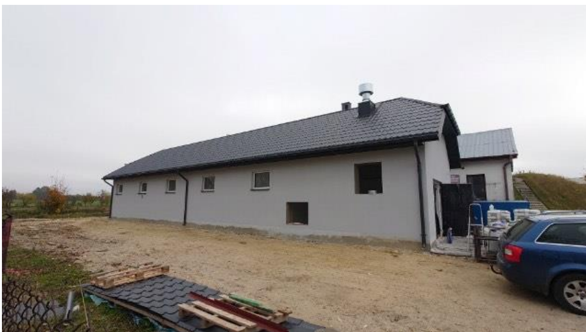
Fotografia 5 Budynek Stacji Uzdatniania Wody w Wólce Nosowskiej
