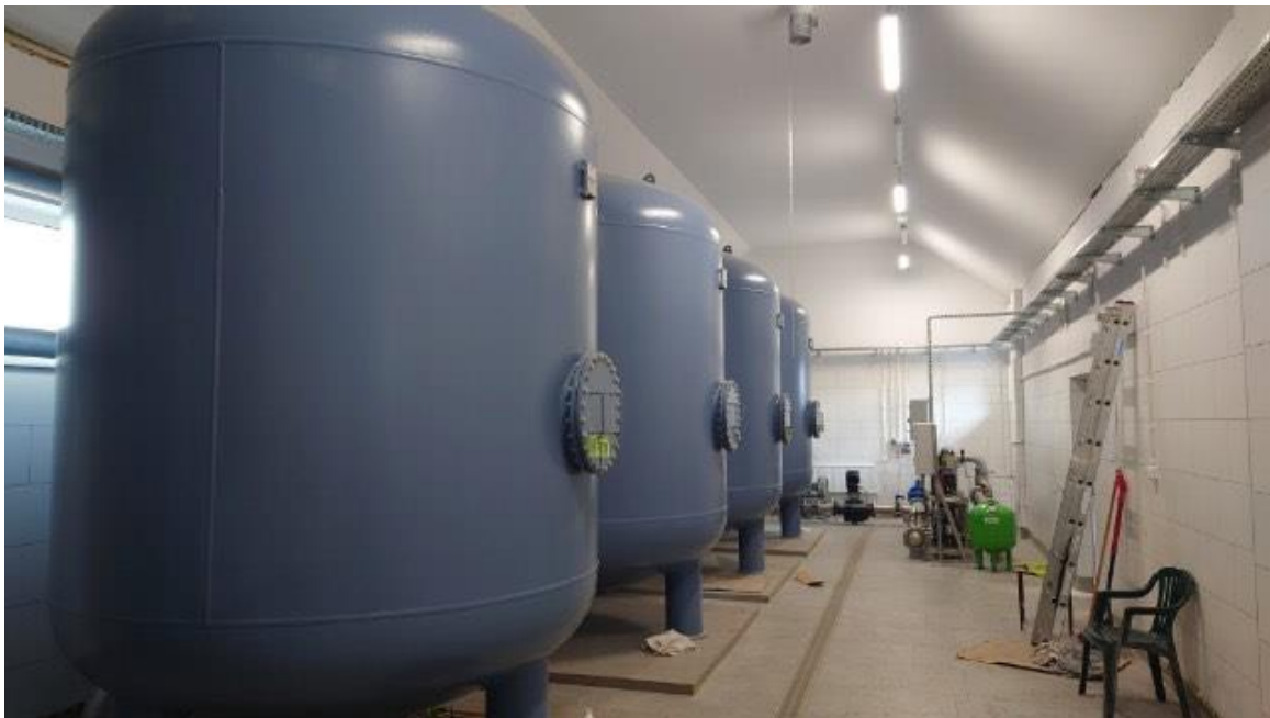
Fotografia 2 Stacja Uzdatniania Wody w Wólce Nosowskiej
