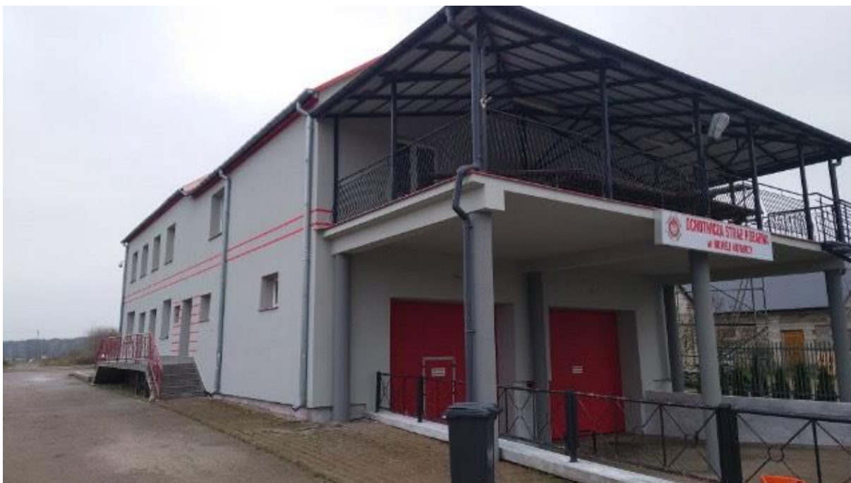
Fotografia 4 Strażnica OSP w Nowej Kornicy
